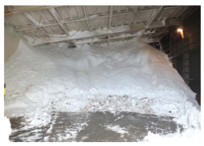
雪のエネルギーを利用した雪蔵貯蔵施設の見学も行った
